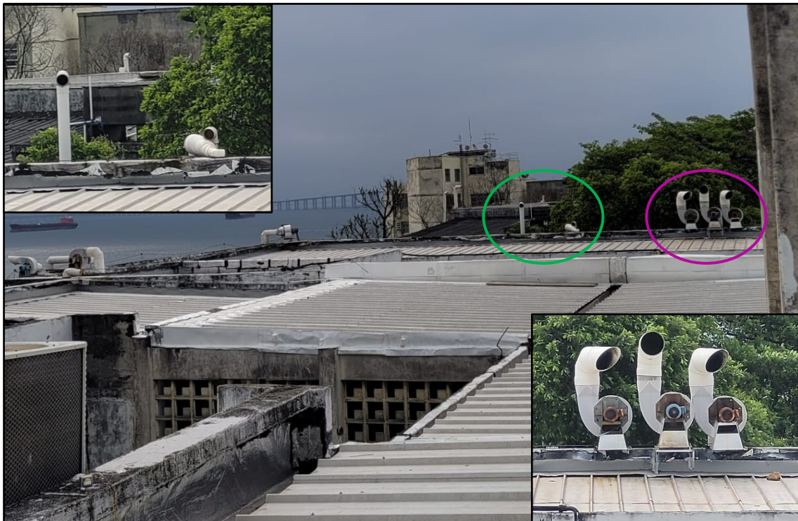
Figura 6 – Vista do Telhado onde está assinalada a tubulação da exaustão do Lab 111 (a verde) e de sistemas do quarto piso (a rosa), com detalhes das respectivas áreas.
