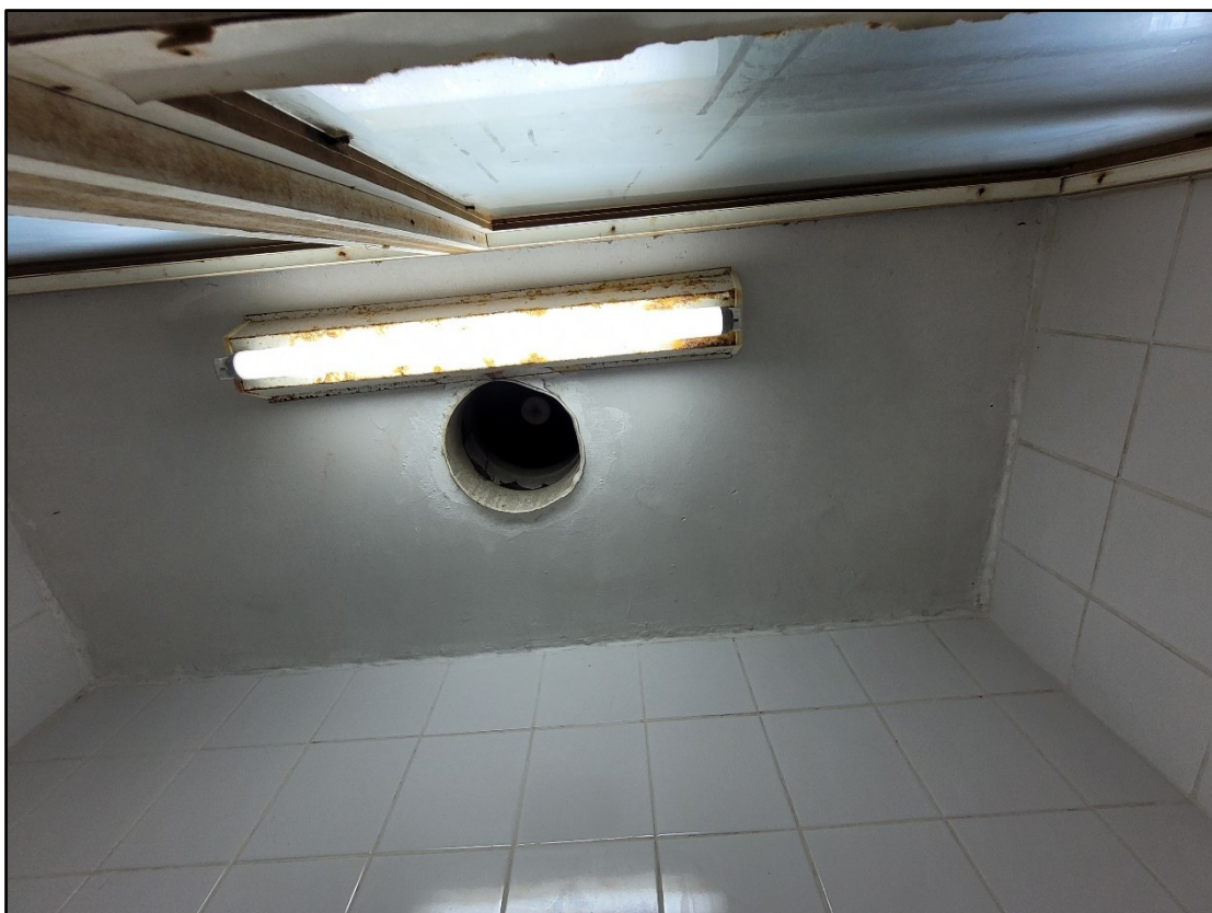
Figura 3 - Capela onde decorreu a reação mostrando as duas posições disponíveis para o posicionamento da janela: aberta (cimo, à esquerda), fechada (cimo, à direita); e exaustão no teto da capela (imagem em baixo).
