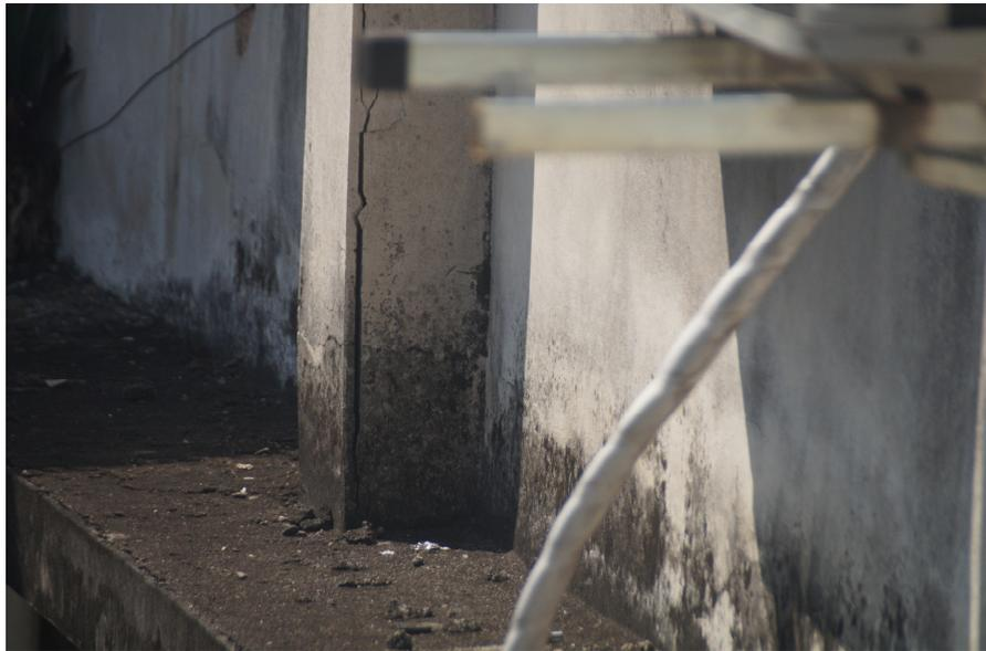
**Figura 3: Visão do 5º andar do Instituto de Química voltada a parede da biblioteca do Departamento de Geoquímica onde observa-se viga com sinais claros de fadiga. Também observa-se pedacos de materiais oriundos da degradação do prédio podem ser observados com risco eminente de queda ao solo com risco considerável a vida humana aos passantes.**
