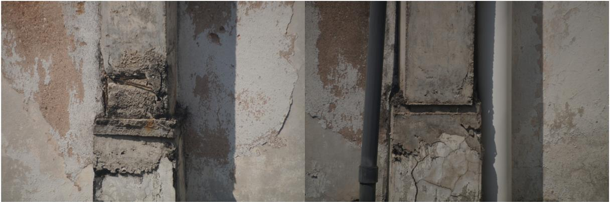
**Figura 8: Visão em detalhe de processos de deterioração em estado avançado da vigas adjacentes as salas de aula do Departamento de Geoquímica do 5º andar do Instituto de Química. Nota-se em detalhe exposição das ferragens das vigas de sustentação em diferentes setores da viga.**
