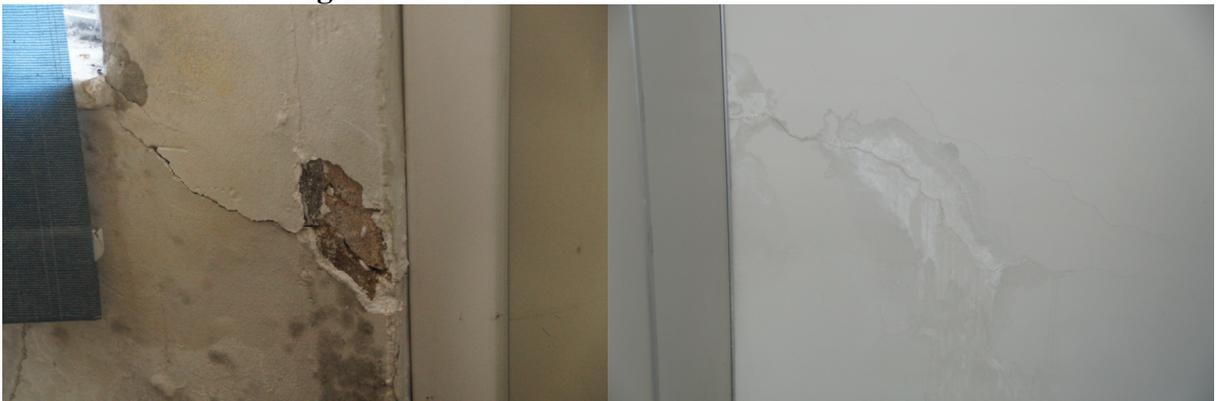
**Figura 9: Visão em detalhe de processos de infiltração em parede interas do Departamento de Geoquímica no 5º andar do Instituto de Química.**
