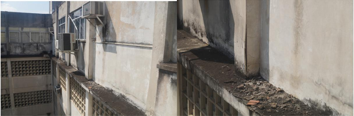
**Figura 2: Visão do 5º andar do Instituto de Química voltada a porção interna observando em primeiro plano a parede da biblioteca do Departamento de Geoquímica e ao fundo a janela da Sala de aula 2 onde observa-se claramente vigas com sinais claros de fadiga com intumescimento da estrutura denotando uma possível colapso estrutural. Pedacos de materiais oriundos da degradação do prédio podem ser observados com risco eminente de queda ao solo com risco considerável a vida humana aos passantes.**
