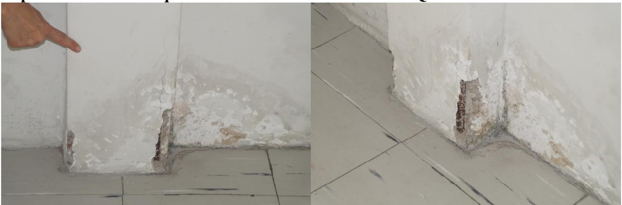
**Figura 9: Detalhe de processos de infiltração em vigas internas do Departamento de Geoquímica no 5º andar do Instituto de Química.**
