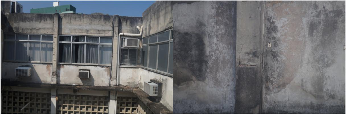
**Figura 6: Visão do 5º andar do Instituto de Química voltada as salas de aula Departamento de Geoquímica. Nota-se em detalhe ausência exposição das ferragens das vigas de sustentação.**
