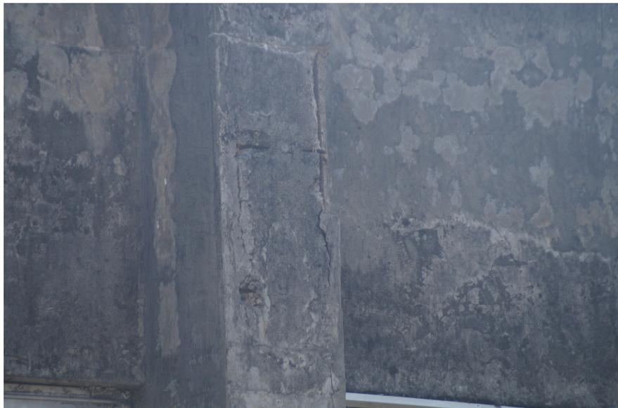
**Figura 5: Visão de viga do 5º andar do Instituto de Química voltada aos gabinetes dos Professores do Departamento de Geoquímica. Nota-se em detalhe ausência total de manutenção com exposição das ferragens da viga .**
