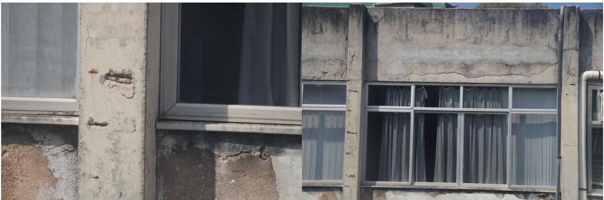
**Figura 7: Visão em detalhe de processos de infiltração nas paredes das salas de aula do Departamento de Geoquímica do 5º andar do Instituto de Química. Nota-se em detalhe exposição das ferragens das vigas de sustentação em diferentes setores da viga.**
