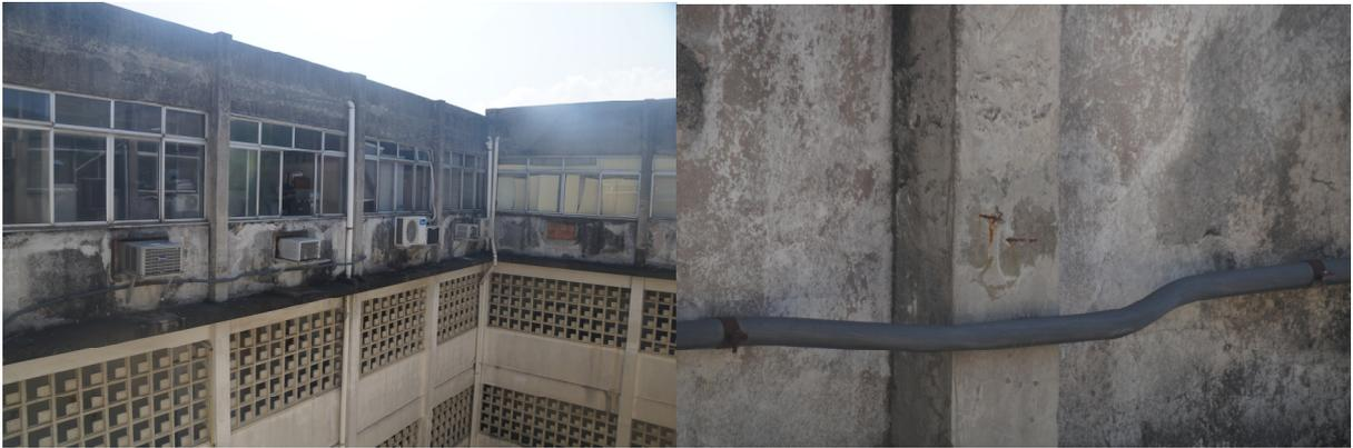
**Figura 4: Visão do 5º andar do Instituto de Química voltada aos gabinetes dos Professores do Departamento de Geoquímica. Nota-se ausência total de manutenção com exposição das ferragens das vigas e ausência de pintura.**
